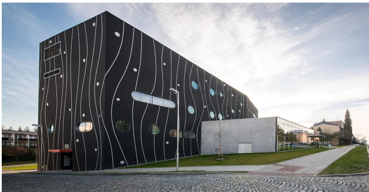
Obr. 1: Budova lékárny FNOL (zdroj. www.atelier-r.cz )
