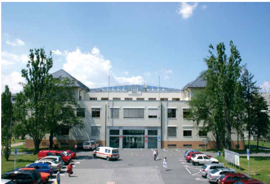
Podoba nově zrekonstruovaného pavilonu A
